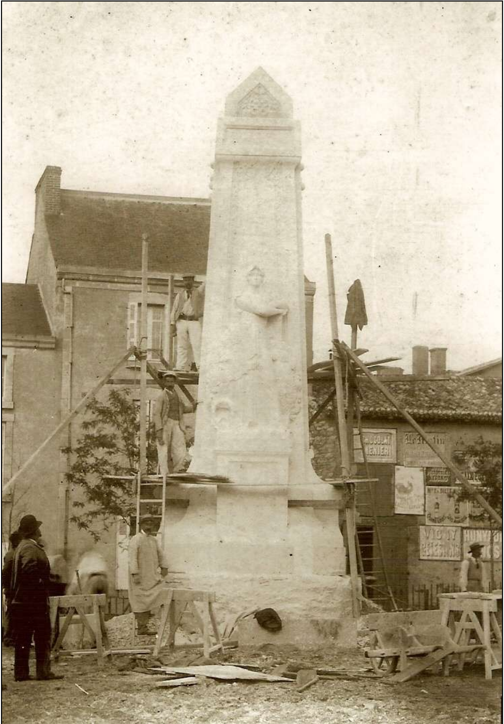
Monument aux morts en construction - Photographie 1902 (Coll. HPB)
